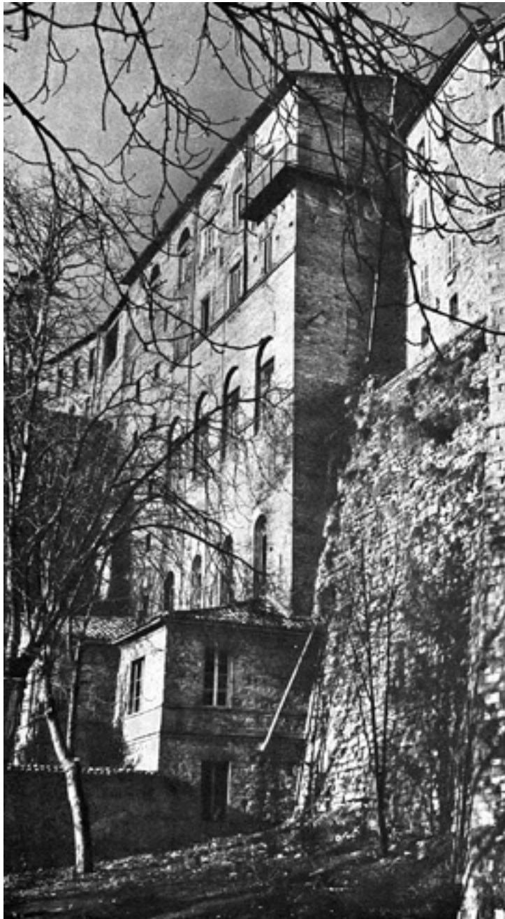
Facciata sud del Palazzo ducale vista dal gioco del pallone; alla sua base si trova l'edificio dell'Istituto di Botanica (inizio 1900); i piani successivi del palazzo sono occupati dai grottoni destinati a tiepidari (piano terra), locali del secondo piano destinati ad aule botaniche ed ora a museo botanico, locali del terzo piano destinati in epoca successiva a Istituto di Botanica, locali del quarto piano (Istituto di Chimica) anni '50 (da RAPONI, 1974).
